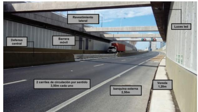
Figura 14: Imagen de los elementos de protección en trinchera.
