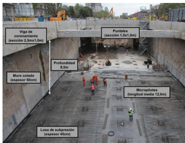
**Figura 10:** Conformación estructural de trinchera en Puerto Madero, etapa constructiva.
